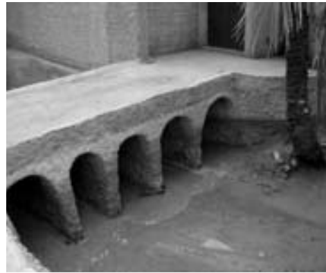
Restauration des ouvrages hydrauliques.
