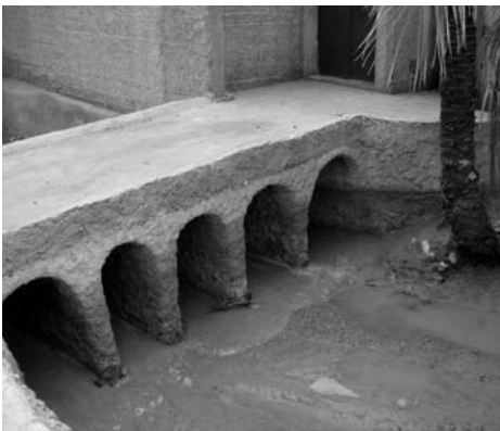
Restauració de construccions hidràuliques.
